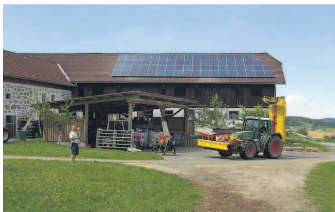
Stromerzeugung aus Sonnenlicht ist gerade auf landwirtschaftlichen Dächern interessant. Die Landwirtschaftskammer OÖ unterstützt die Bauern bei vielen Anfragen zum Thema Photovoltaik. DANNINGER
